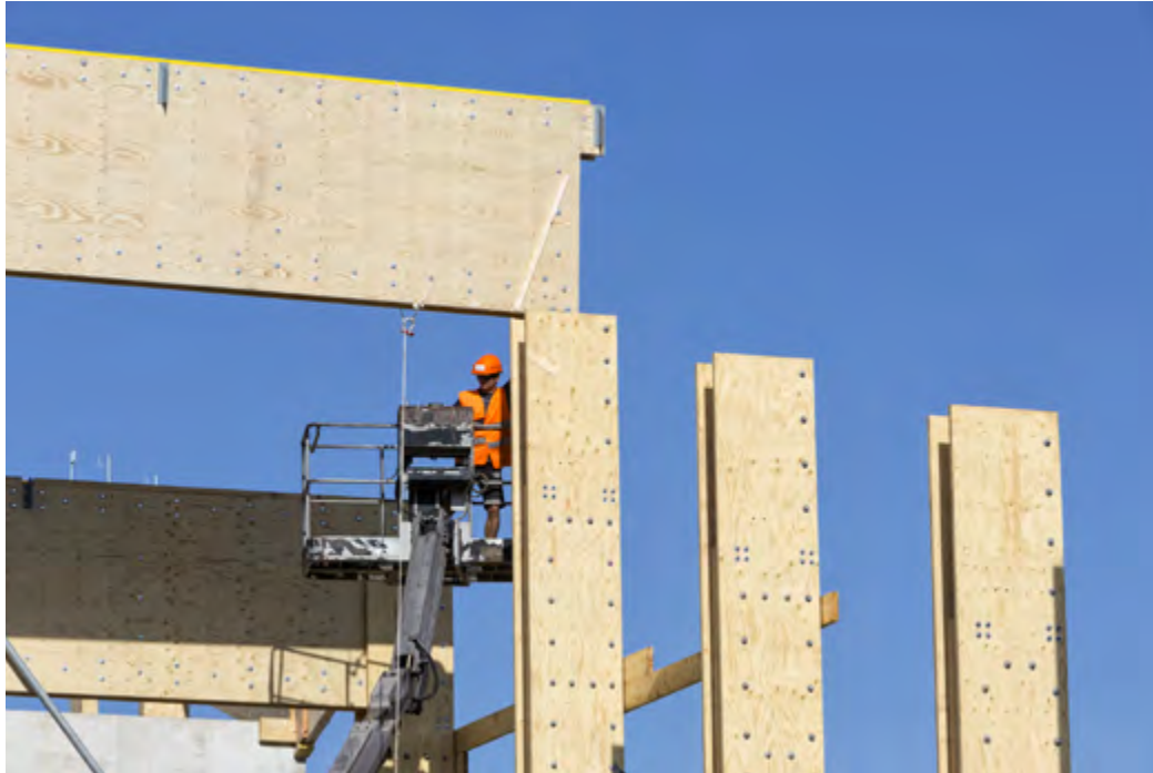
assemblage poteau poutre préfabriqué
